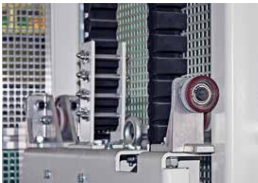
Konsolenführung über Vulkankanrollen
