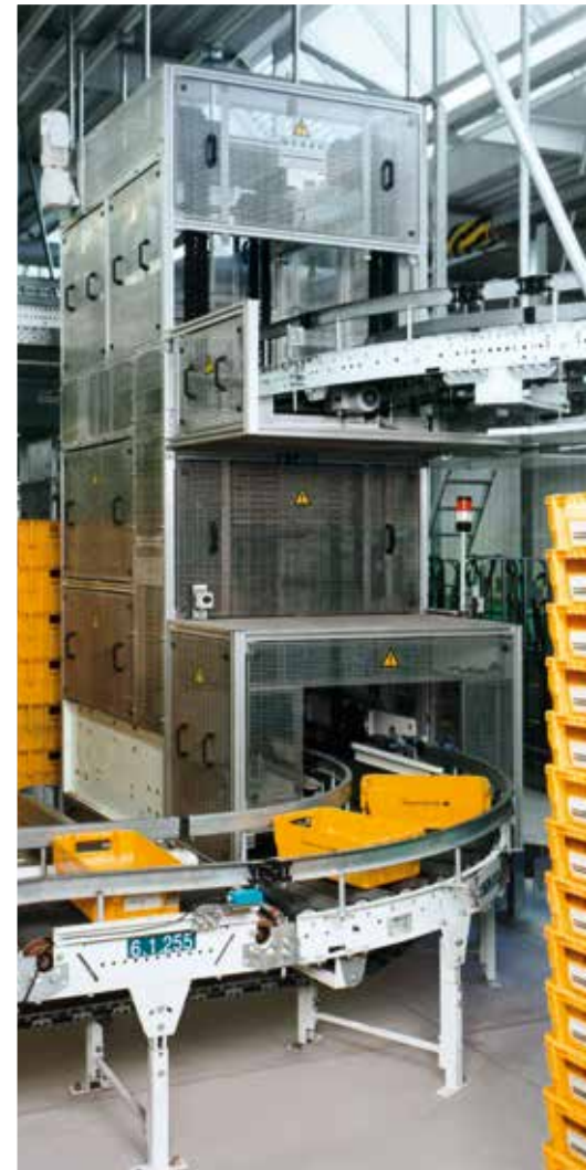
C-Förderer im Briefverteilzentrum
